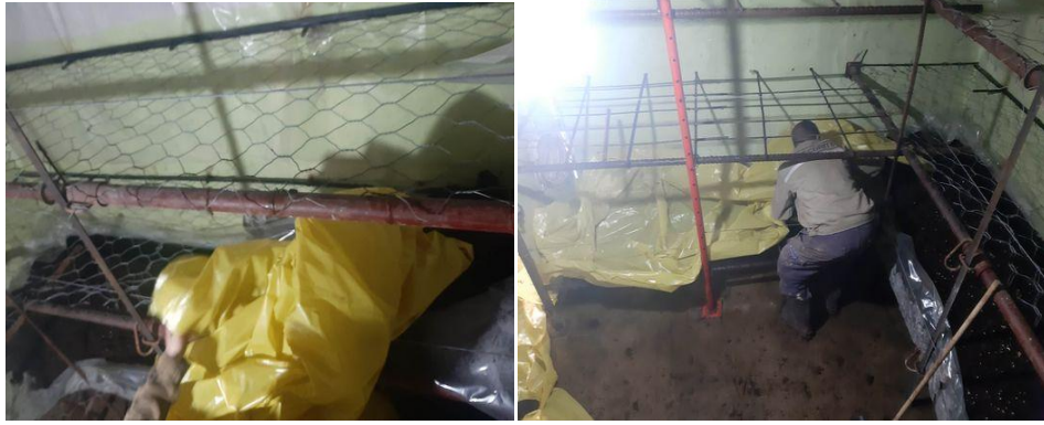
الشكل 26 صور تجهيز الرفوف الحديدية
